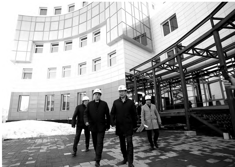
Строительная площадка самого большого детского образовательного центра Мирнинского района. / ФОТО: АНДРЕЯ СОРОКИНА
